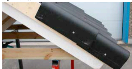
Рис. 11 Прикрепляйте боковую универсальную черепицу, предварительно просверлив в ней отверстия для крепления.
