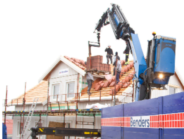
Рис. 1 Для подъема черепицы на крышу используйте только предназначенную для этого технику с вилочным грейфером.
