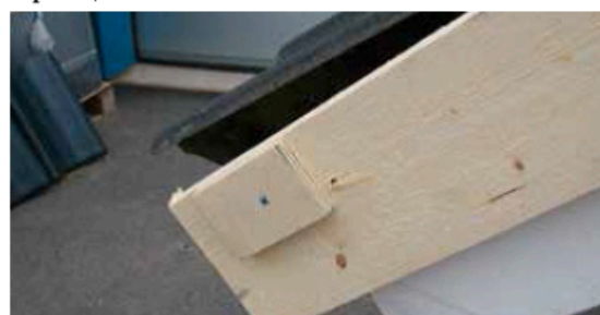
Рис. 9 Прикрепите дополнительный деревянный брусок к ветровой доске.
