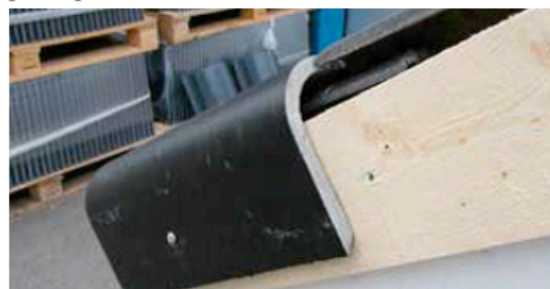
Рис. 8 Отрежьте более тонкую часть верхнюю часть боковой черепицы.
