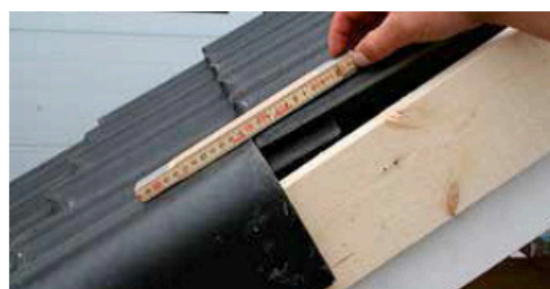
Рис. 10 Боковая универсальная черепица всегда должна быть на одном уровне (на одной высоте) с рядом черепиц над ней
