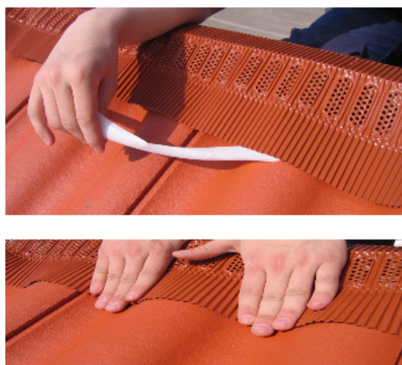
Рис.14 Вентиляционная коньковая лента укладывается поверх конькового бруса и "пристреливания" скобами. Снимите защитную пленку с тыльной стороны ленты и хорошо прижмите липкие края к поверхности черепицы. Температура воздуха должна быть не ниже +5°C, а поверхность черепицы, на которую приклеивается лента должна быть чистой и сухой. Прокатайте соединение валиком.
